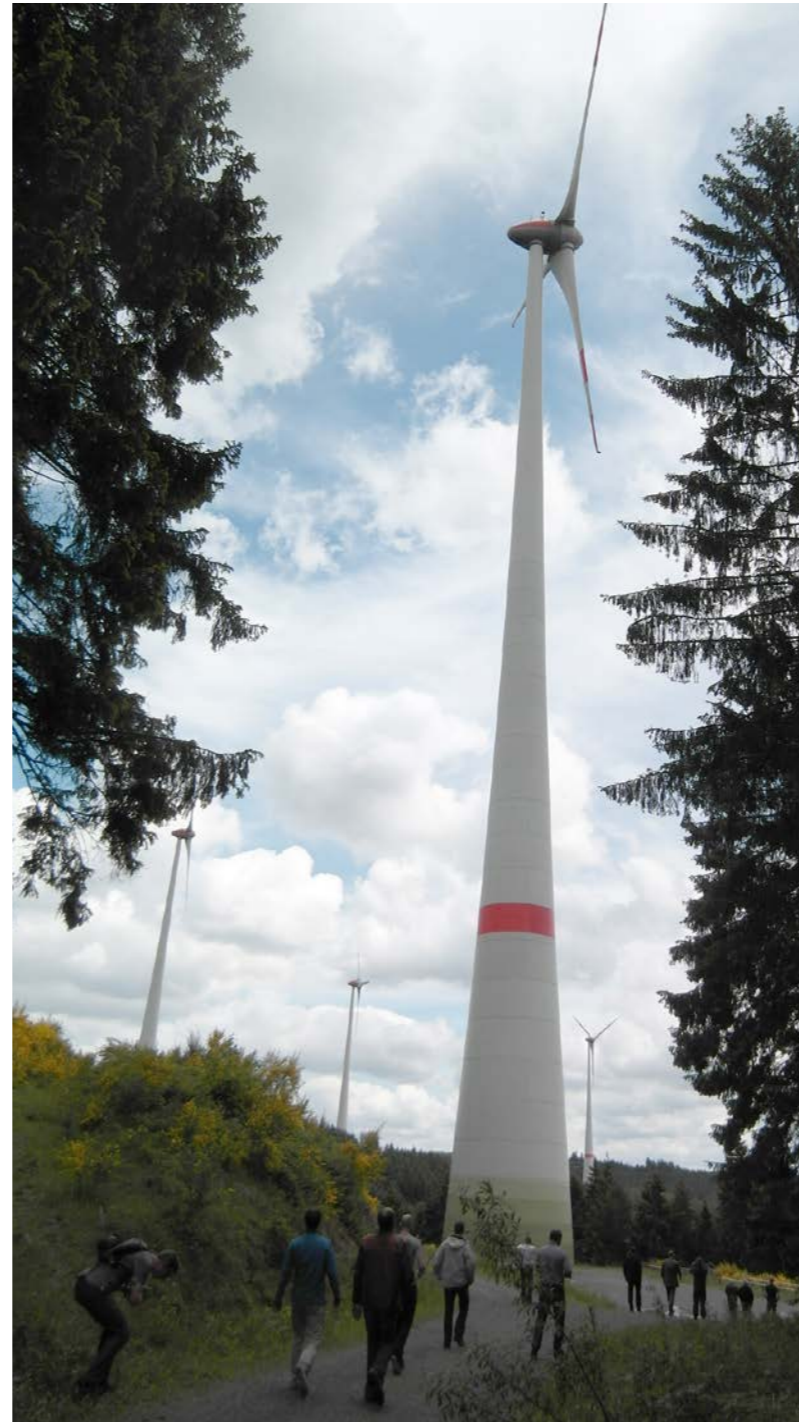
Besichtigung der Windfarm Ellern der juwi GmbH im Rahmen des Workshops Windenergie im Wald am 20.09.2013 in Koblenz.
